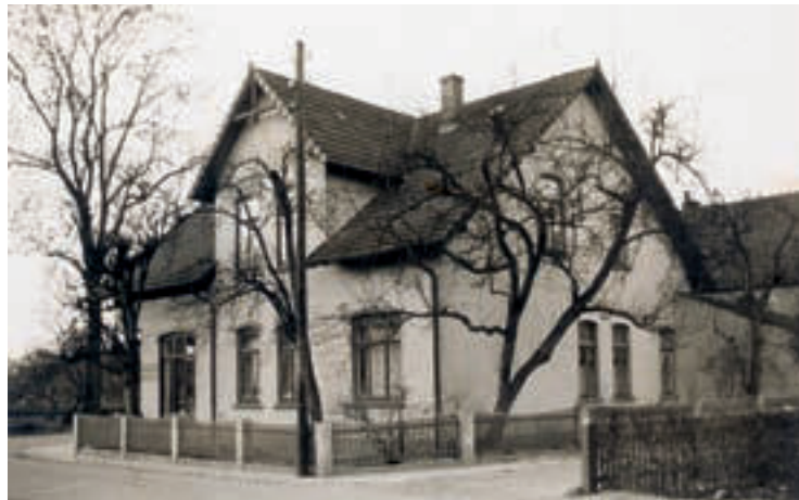
Abb. 19: Bösch Geschäftshaus von 1913 aus der Bahnhofstraße betrachtet
