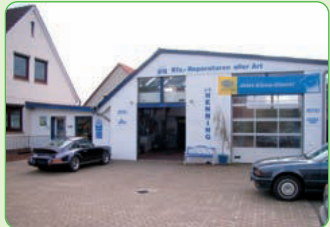
Abb. 4: Kfz.-Reparaturwerkstatt H. P. Henning
