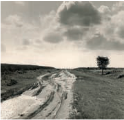
Abb. 5: Der Königsdamm vor dem Ausbau um 1950; von der Hepstedter Straße in Richtung Neu St. Jürgen
