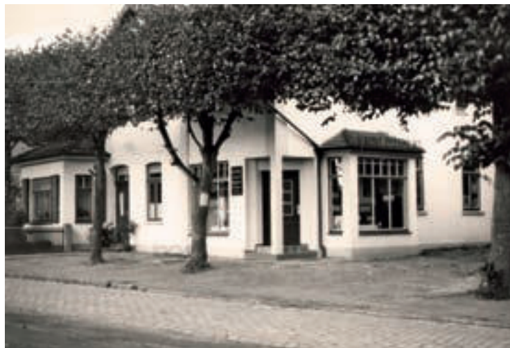
Abb. 22: Das Geschäftshaus vor 1958
