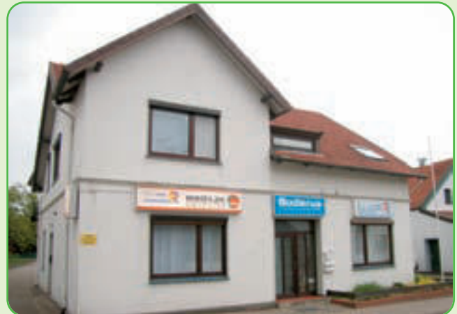
Abb. 4: Heizung und Sanitär Riss
