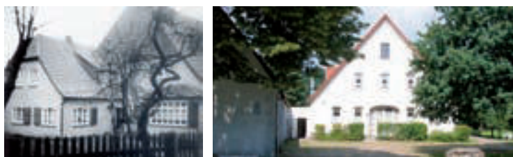
Abb. 14a und b: Der in den 1950er Jahren angebaute Wohntrakt und die heutige Ansicht
