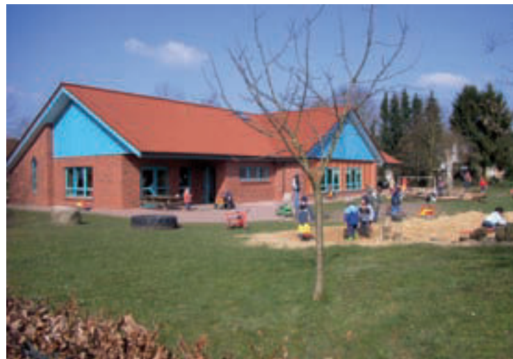
Abb. 22: Der Kindergarten im Fasanenweg
