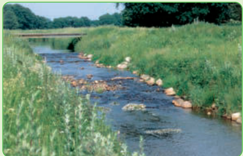
Abb. 3: Nach der Renaturierung mit Sohlgleite im Jahre 1997
