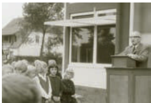
Abb. 8: Einweihung des Erweiterungsbaus durch Bürgermeister Hermann Knoop
