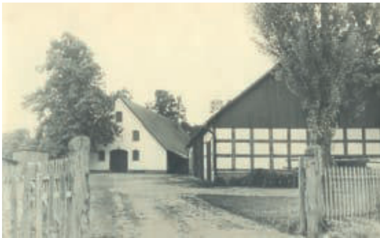
Abb. 10a: Die Ansicht des Hofes von der Bauernreihe
