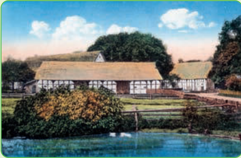
Abb. 1: Blick auf Kahrs Hofstelle („Bohlens“) in der Bauernreihe
