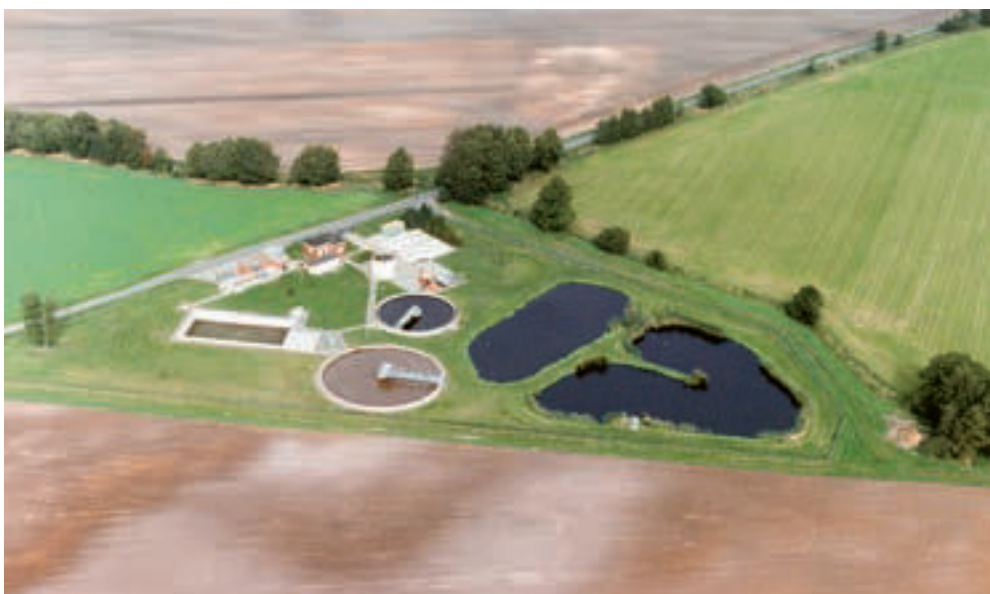
Abb. 13: Das Tarmstedter Klärwerk
