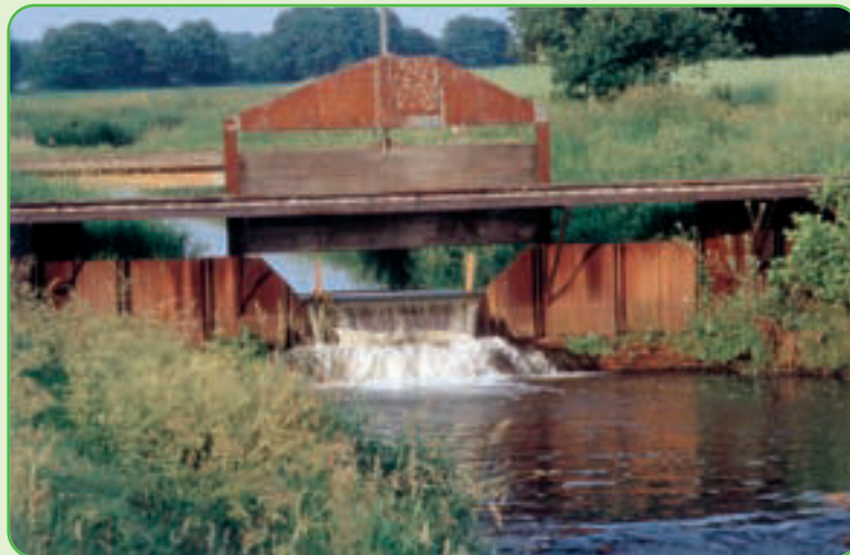
Abb. 2: Die Wörpe mit Sohlabsturz beim Klärwerk (1993)
