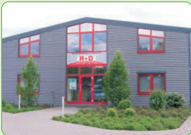
Abb. 3: Akustik- und Trockenbau Rosenbrock + Demmler
