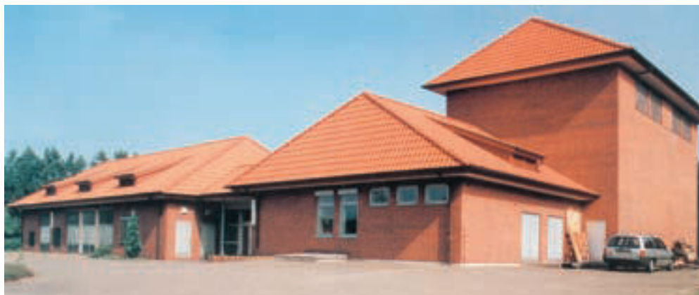
Abb. 12: Das Wasserwerk Tarmstedt (links das Maschinenhaus, in der Mitte die Steuerungszentrale und rechts das Gebäude mit den Wasserfiltern)
